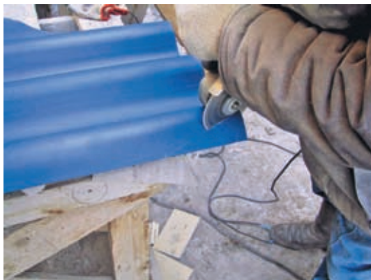
Рис. 2.19. Способы подрезки углов хризотилцементных листов: а) подрезка листа с помощью дисковой пилы; б) подрезка листа на деревянном шаблоне; L – величина продольной нахлестки листов
