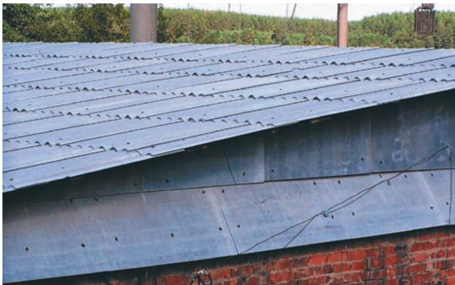
Рис. 2.30. Односкатная вентилируемая кровля конструкции «УРАЛ-2А»
