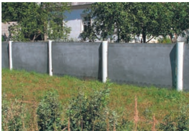
Рис. 3.45. Заборы из хризотилцементных материалов
