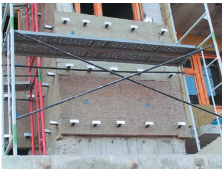
Рис. 3.29. Установка утеплителя
