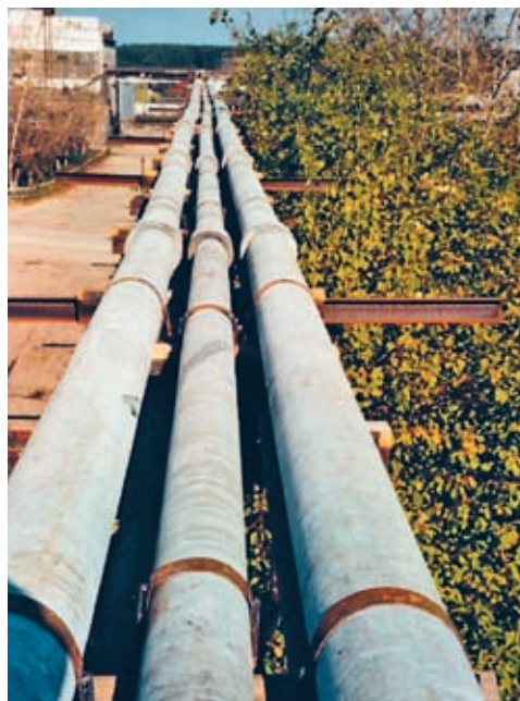
Рис. 4.16. Надземная прокладка хризотилцементных труб на высоких опорах до монтажа теплоизоляции
