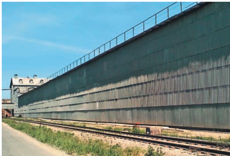
Рис. 2.34. Промышленное здание с вентилируемым фасадом конструкции «УРАЛ-1»
