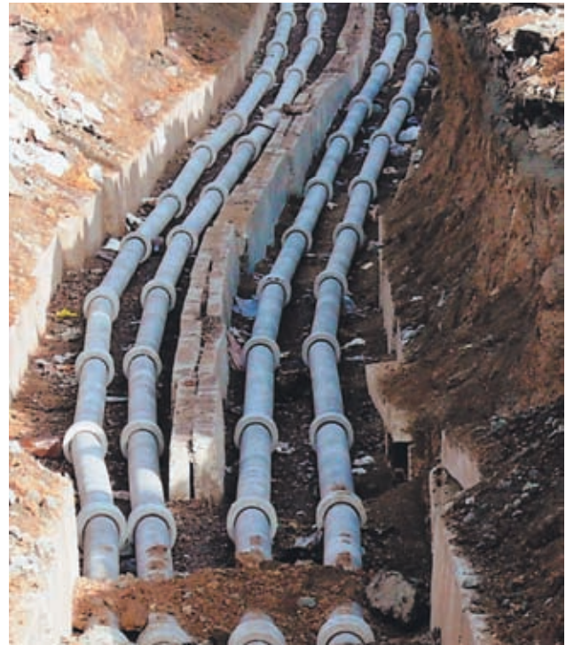
Рис. 4.29. Трубопровод из хризотилцементных труб (допустимое искривление трассы)
