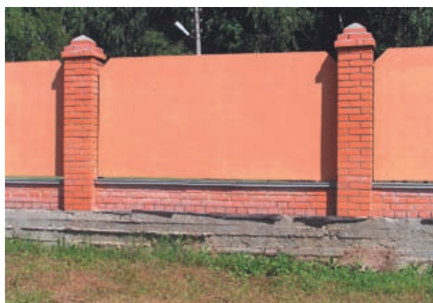
Рис. 3.45. Заборы из хризотилцементных материалов
