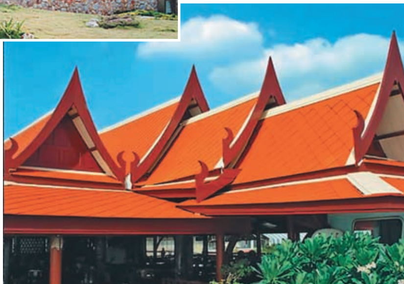
Рис. 6.3. Хризотилцементная кровля и фигурные элементы
