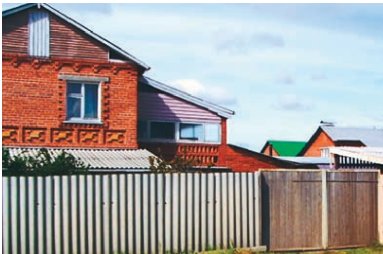
Рис. 2.37. Оформление забора волнистыми хризотилцементными листами
