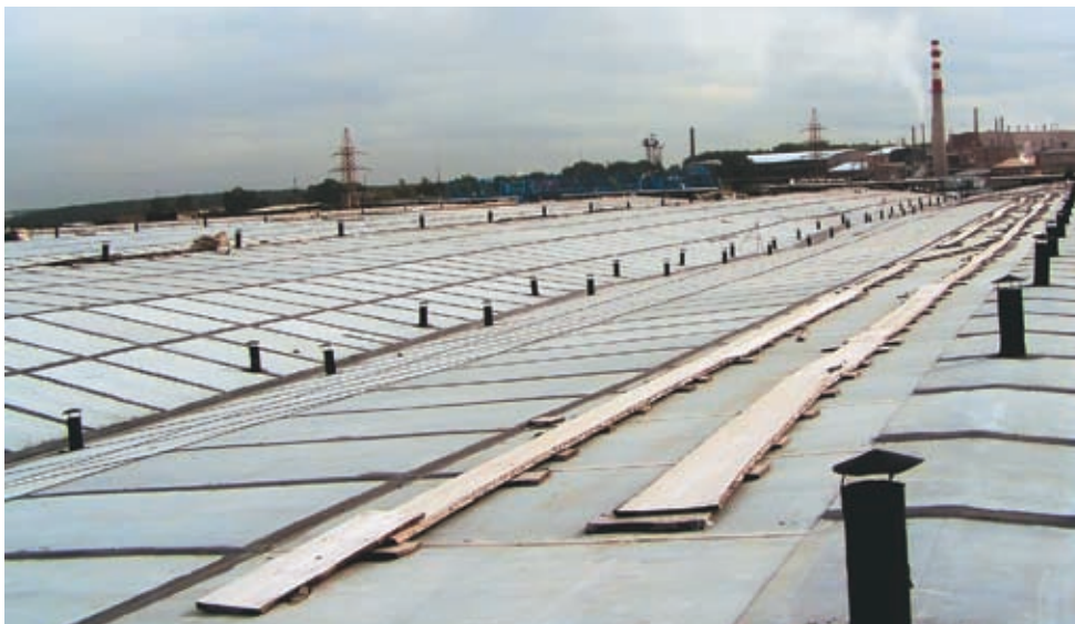
Рис. 3.17. Вид кровли из плоского хризотилцементного листа
