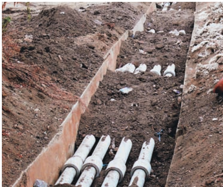
Рис. 4.31. Смонтированный трубопровод перед гидравлическими испытаниями
