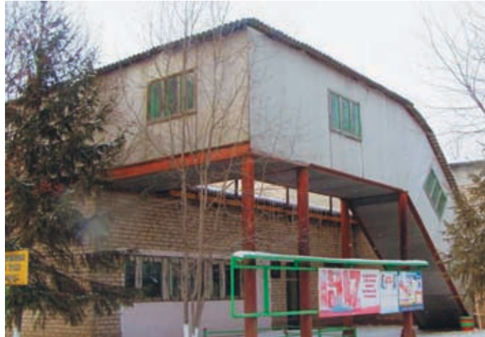
Рис. 3.41. Галерея из плоских хризотилцементных листов – переход между промышленными зданиями
