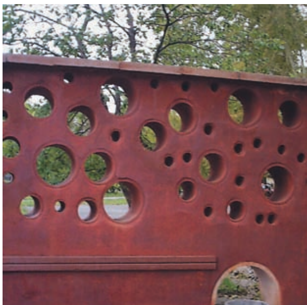
Рис. 4.48. Декоративное ограждение с использованием хризотилцементных колец
