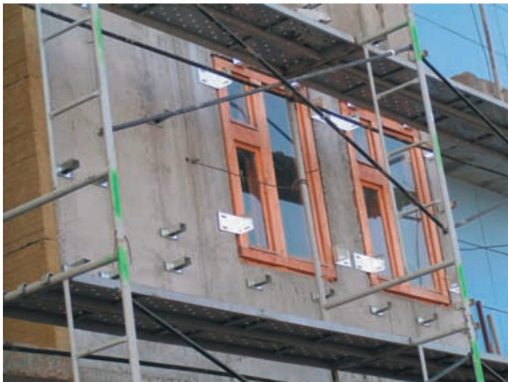
Рис. 3.28. Установленные на стене кронштейны несущего каркаса
