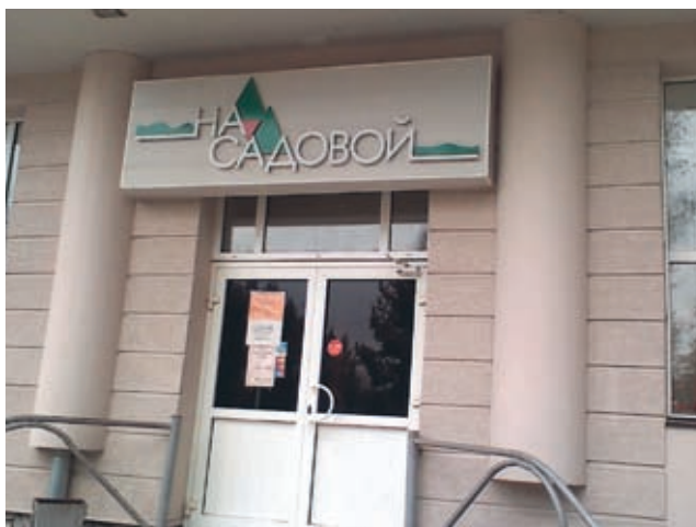
Рис. 4.47. Фасад магазина, оформленный с применением полуцилиндров из хризотилцементных безнапорных труб
