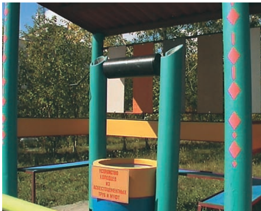
Рис. 4.50. Колодец и опоры для навеса из хризотилцементных труб, навес – из волнистого хризотилцементного листа
