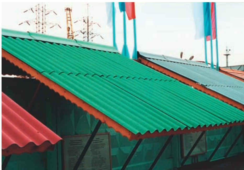
Рис. 2.36. Навес из хризотилцементных листов
