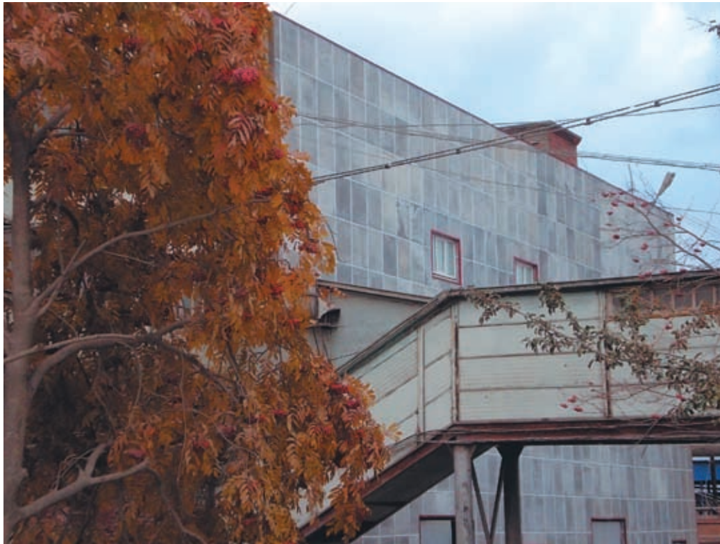
Рис. 3.25. Здание промышленного корпуса
