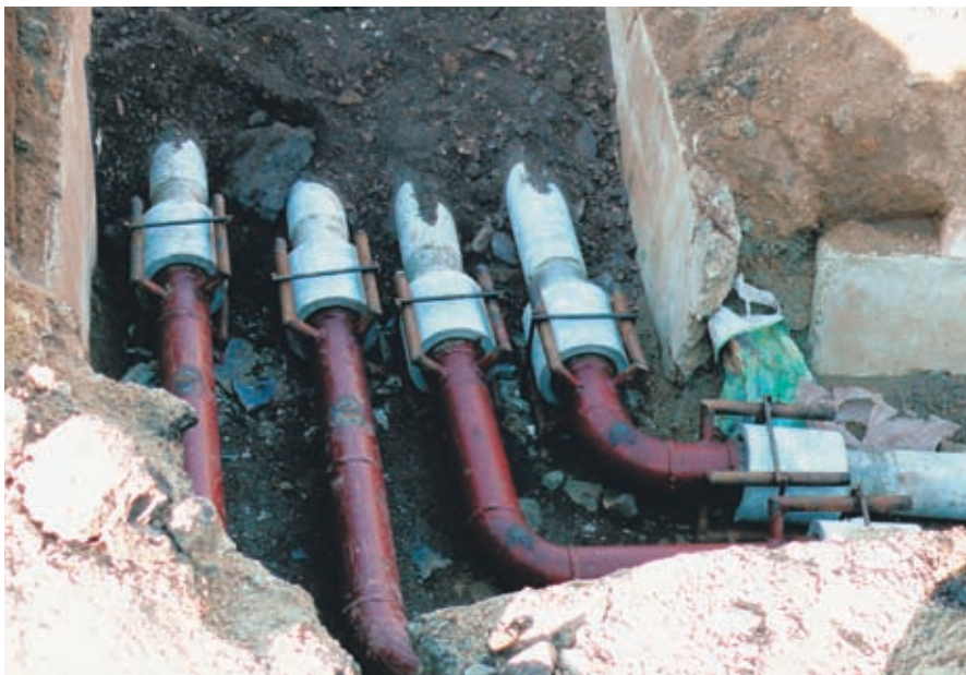
Рис. 4.20. Угол поворота трассы перед заливкой бетоном
