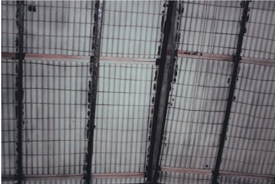
Рис. 4.37. Перекрытие из хризотилцементных труб (вид снизу)
