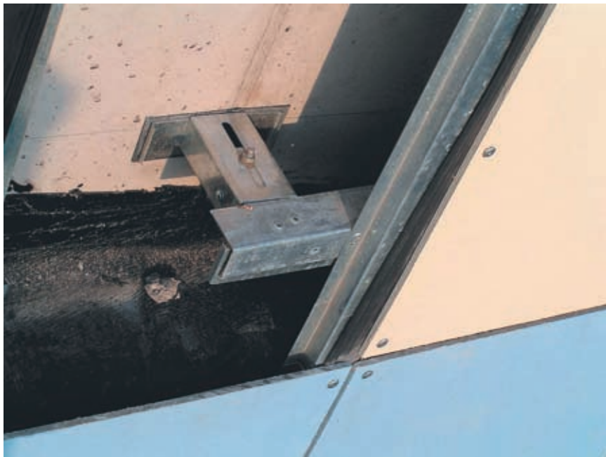
Рис. 3.30. Монтаж хризотилцементных фасадных плит
